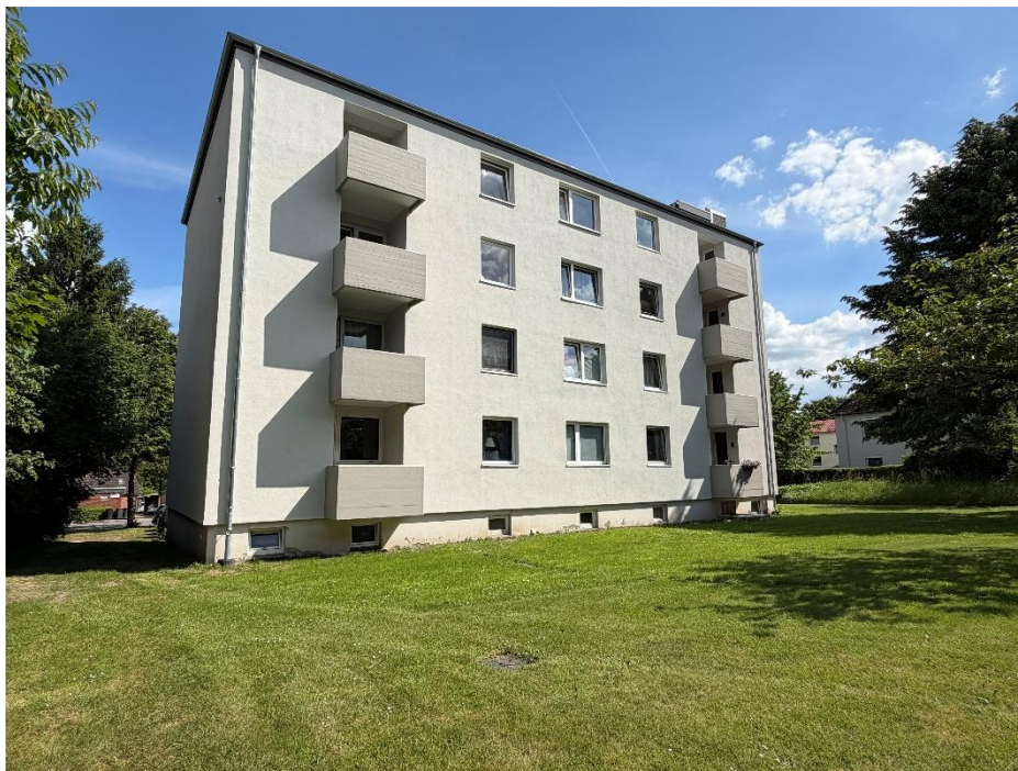
Estetalstraße 28 nach Instandsetzung der Fassade.
